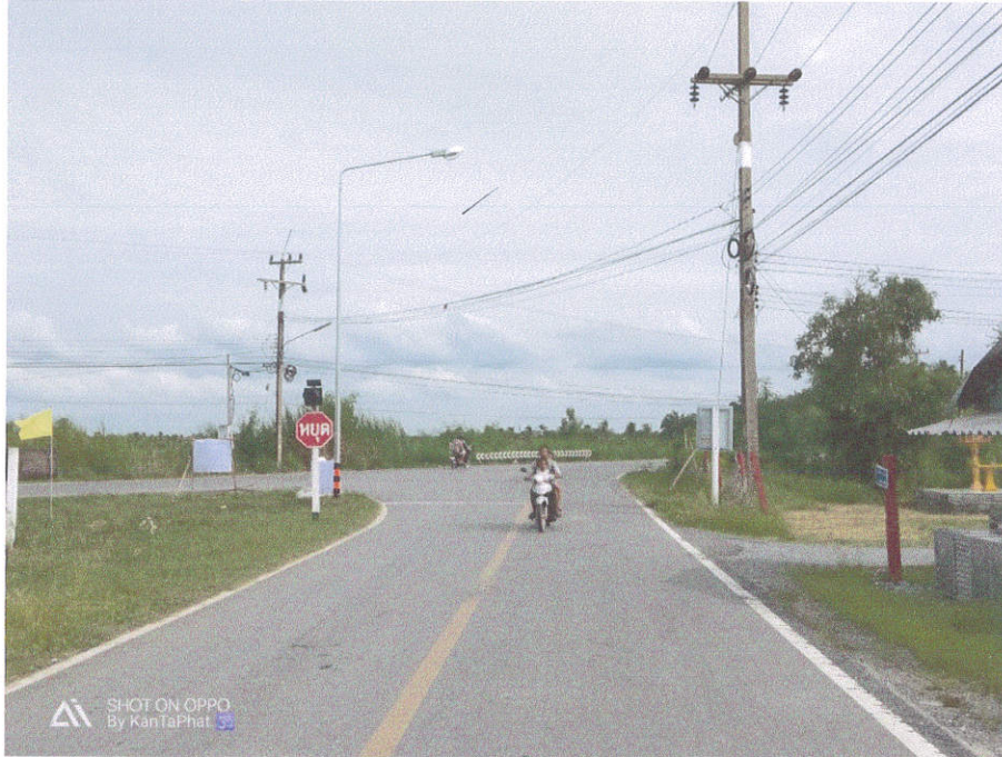
จุดที่ 3 ส้มแยกทางเข้าวัดทรงบน
